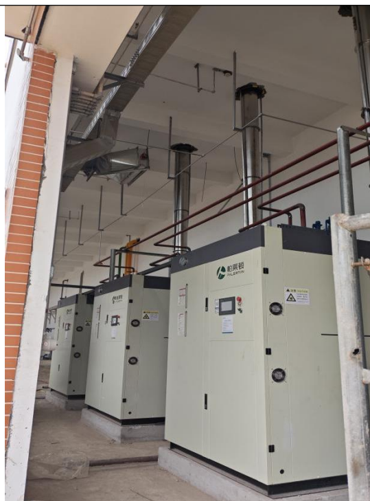
已安装的 3 台热燃机
