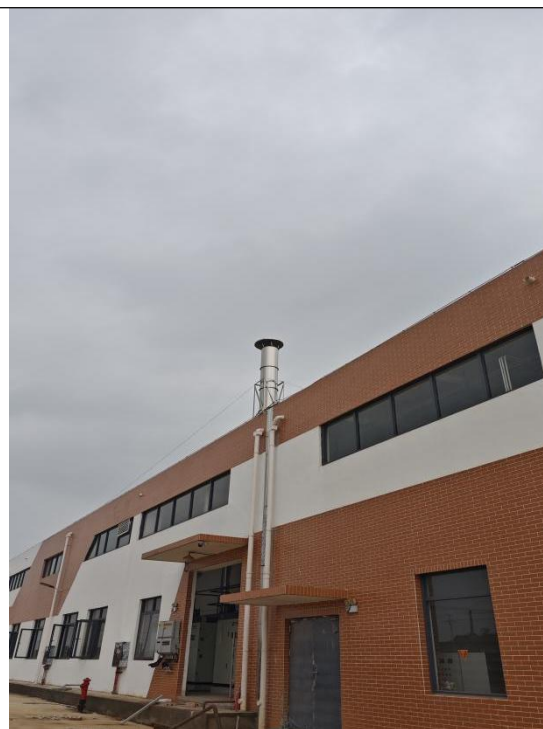
热燃机排气筒
