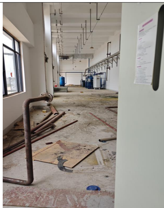
预留安装热燃机空间（热燃机房）
